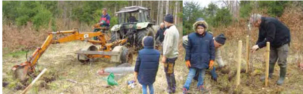
Technische Hilfe: Hans Geiger sen. beim Aushub der Pflanzlöcher...
