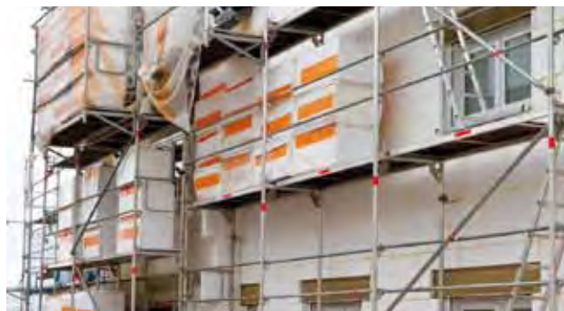
Gebäudedämmung: Maßnahme mit großem Energiesparpotenzial.
