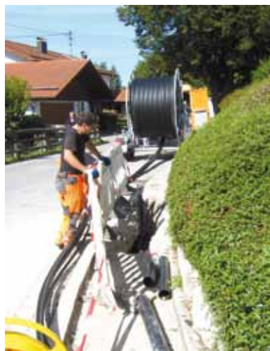
Nehmen wahlweise Glasfaser- oder Kupferleitungen auf: die frisch verlegten Leerrohre.
