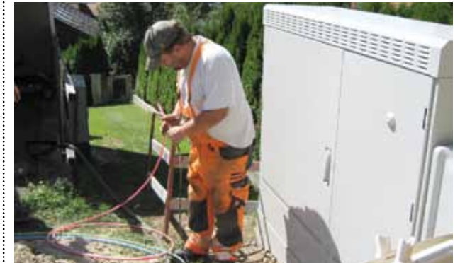
Bereits aufgestellt: die neuen Multifunktionsgehäuse.
