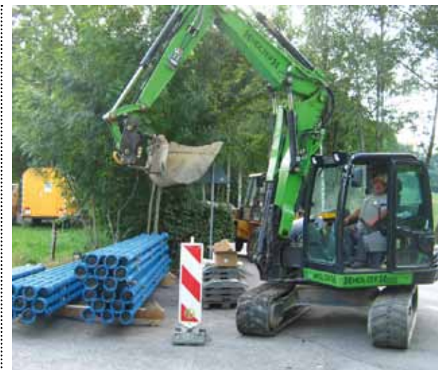
Neue Leitungen in Ambach: Gusseisen statt Asbestzement.
