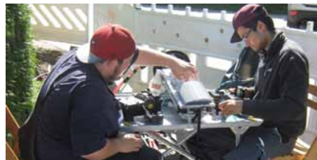
Spezialistenarbeit: das Verspleißen der Glasfaserleitungen.
