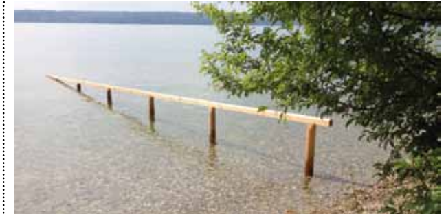
Bequemer Zugang: die neue Einstiegshilfe am Badeplatz Nord.
