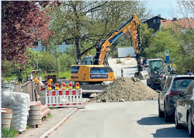
Herausforderung für die Anwohner: die Bauarbeiten in Mörlbach.
