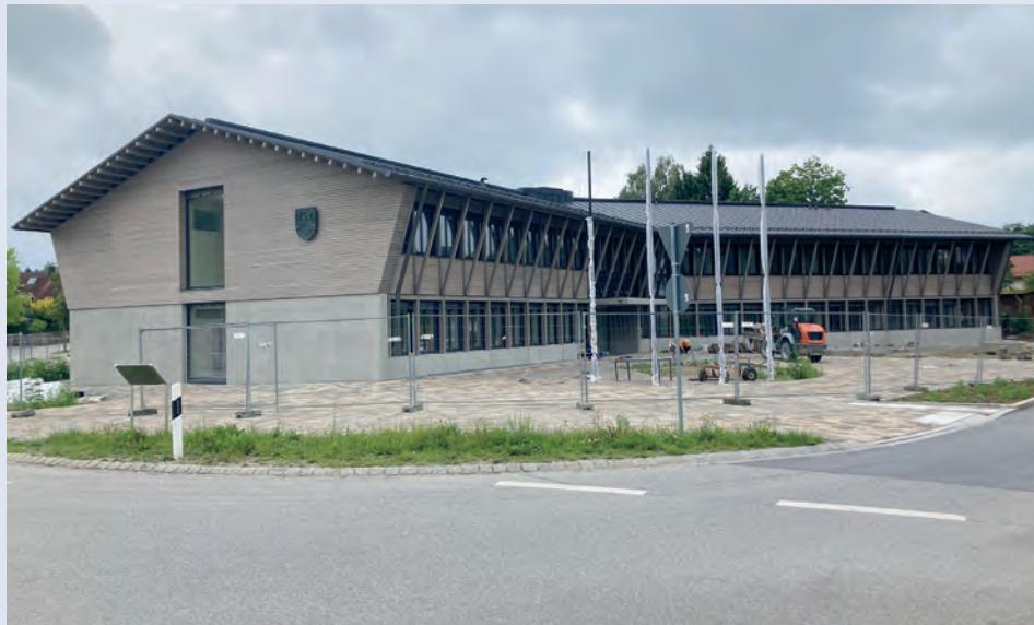
Die Außenanlagen kommen voran, die Fahnenmasten sind bereits gesetzt.
