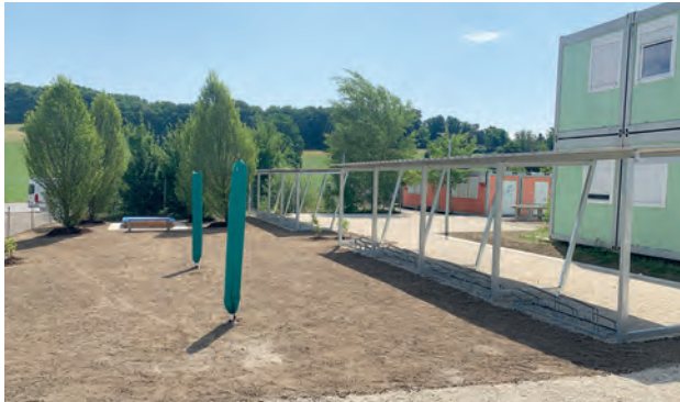
Mit Außenfläche und Sandkasten zeigt sich die erweiterte Anlage.
