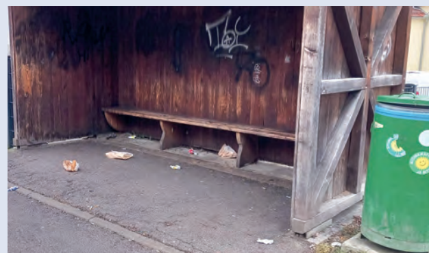
Berger Bushaltestelle: Abfall am Boden, Müllbehälter steht daneben.
