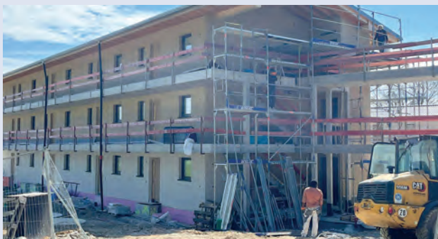
Nach Punkten vergeben: die Wohnungen an der Osterfeldstraße.
