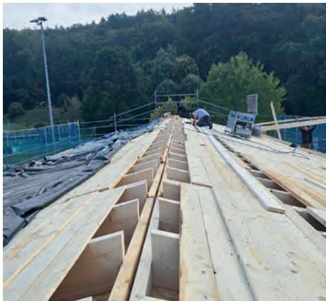
Aus vorgefertigten Bauteilen zusammengefügt: das neue Sport- und Funktionsgebäude des MTV Berg.
