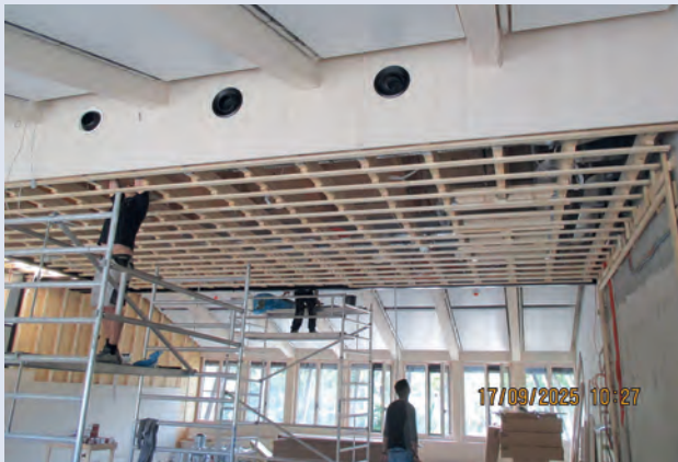
Kurz vor der Fertigstellung: die Deckenverkleidung im Sitzungssaal ...
