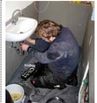
Letzte Handgriffe: Installateur Feistbaur bei der Montage.
