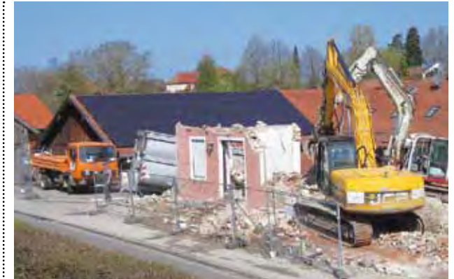
Platz schaffen für etwas Neues: der Abriss des Milchhäusls.
