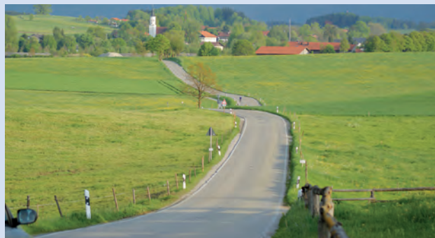
Kreisstraße Münsing-Degerndorf: Fertigstellung bis Mitte 2020.
