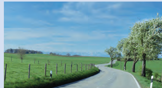
Staatsstraße Münsing-Holzhausen: Sanierungsbeginn 2020/21.
