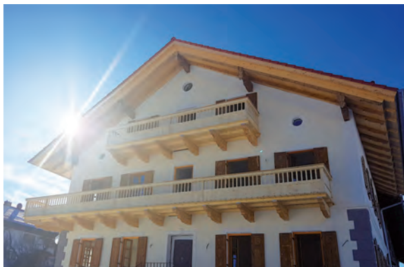
Komplettsanierung 140 Jahre altes Bauernhaus in Degerndorf
