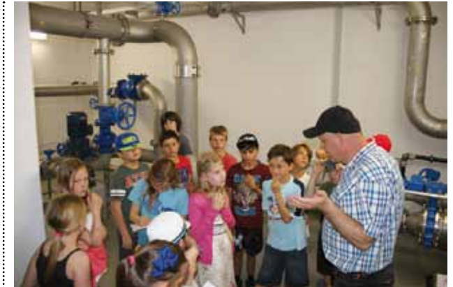
Herr Limm von der Gemeinde erklärt die Trinkwasserversorgung.
