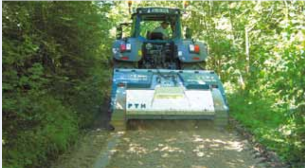
Nur wieder neuen Kies auffüllen reicht nicht – mit Fräse und...
