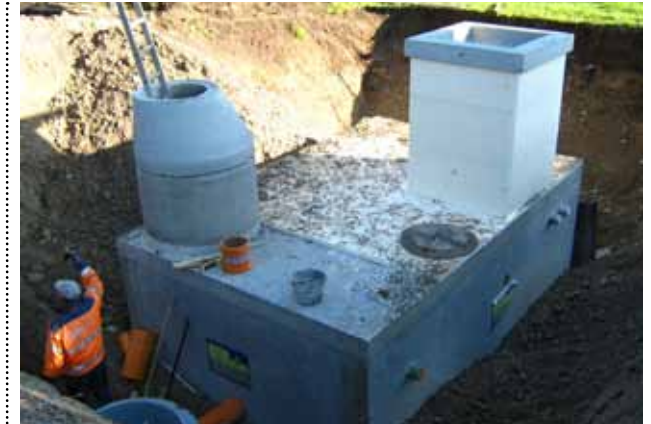
Die Montage der neuen Abwasser-Pumpstation in Weipertshausen.
