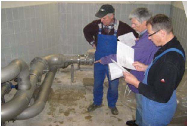
Mit kritischem Blick auf die neue Anlage: Wasserwart Josef Paulus, Planer Manfred Kehrer und ein Mitarbeiter der Firma WILO EMU bei der Abnahme der Hydraulik (v. li.).
