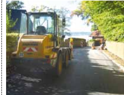
Erfolgreiche Sanierung: die Pfaffenkamer Straße in Seeheim.
