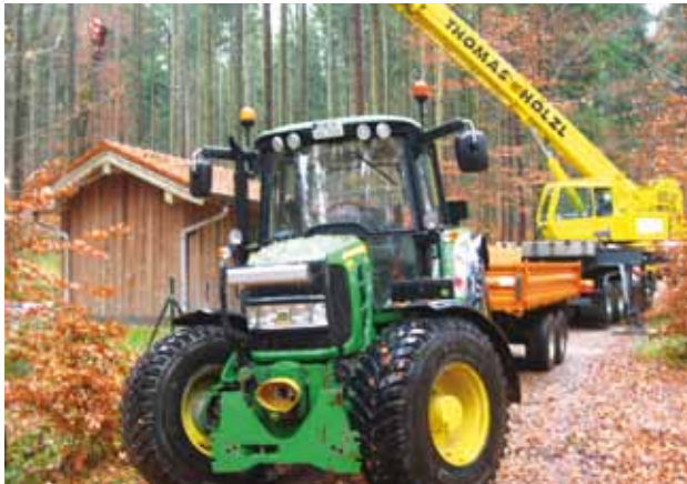
Schweres Gerät im Einsatz: Pumpenwechsel in Ammerland.
