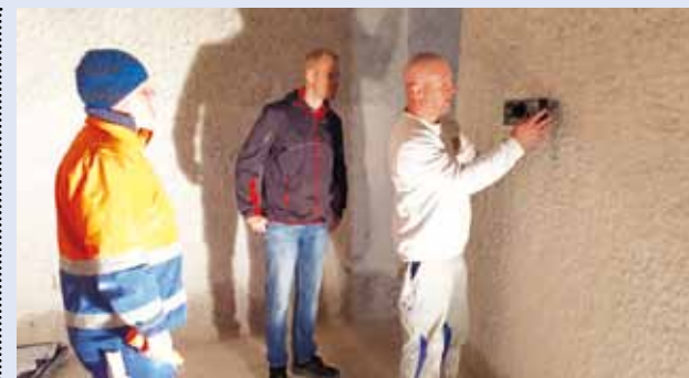
Prüfen der Betonqualität in der Wasserkammer des Hochbehälters.
