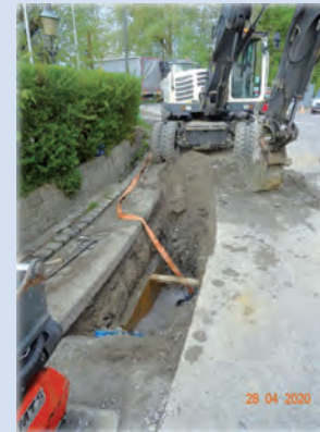
St. Heinrich: Verlegung einer neuen Hauptleitung, Neuanschluss und Hydranten.
