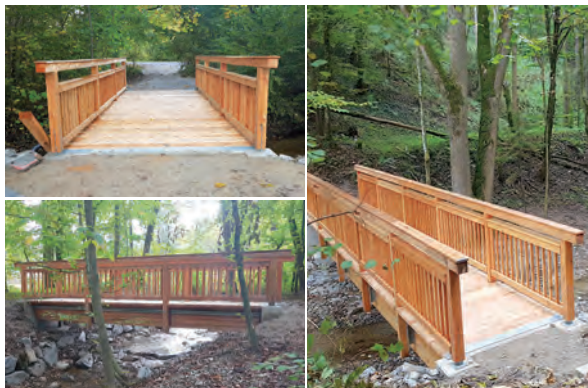
Drei neue Holzbrücken im Gemeindegebiet
