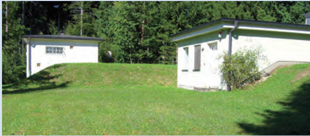
Renovieren oder erneuern? Die Hochbehälter in Weisenkam.
