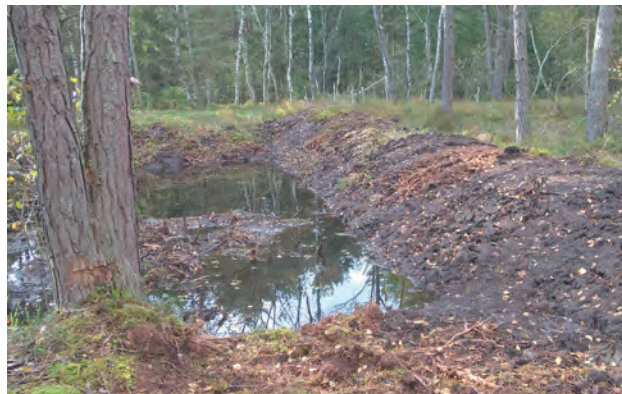
Kaum ist der Damm fertig, zeigt sich schon der erste Anstau effekt.
