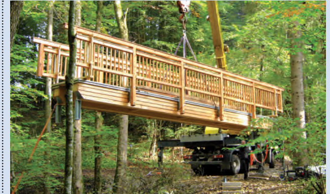
Mit dem Kran an ihren Platz gesetzt: die Brücke bei Weidenkam.
