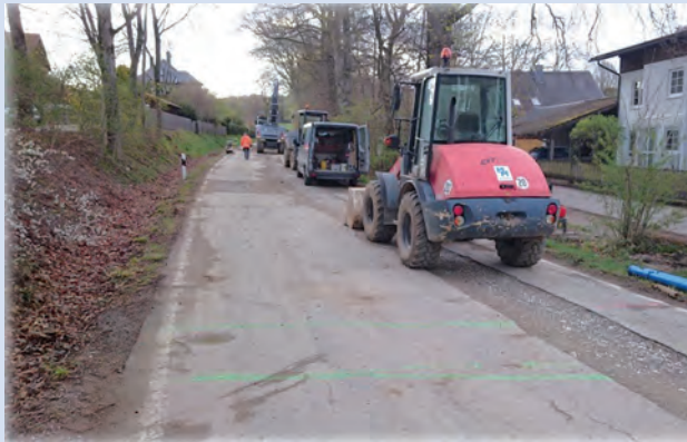
Verlegung einer neuen Hauptleitung, drei neue Hausanschlüsse...
