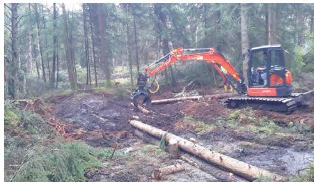
Ein Damm wird gebaut, im Hintergrund ist er schon fertig, das Holzgerüst im Vordergrund wird noch mit Torf überwallt.
