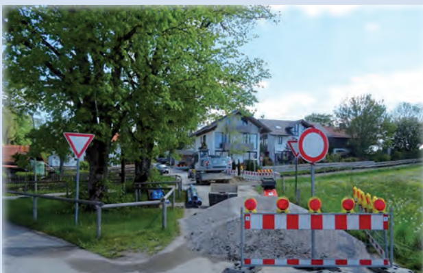
Verlegearbeiten am Hauserweg in Münsing.
